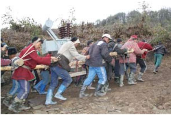
写真5 変圧器運搬（2011年3月、メラック地区）
